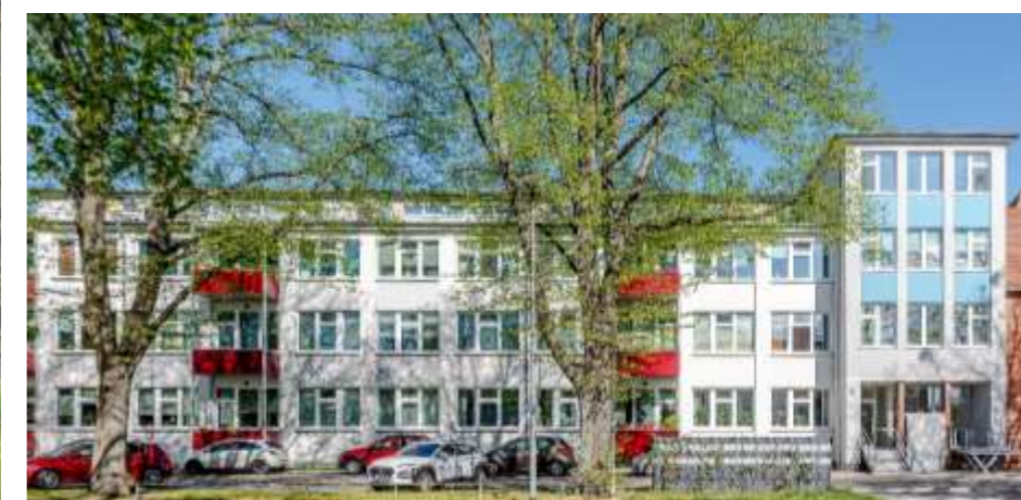
Krankenhausumbau – in Neubrandenburg
