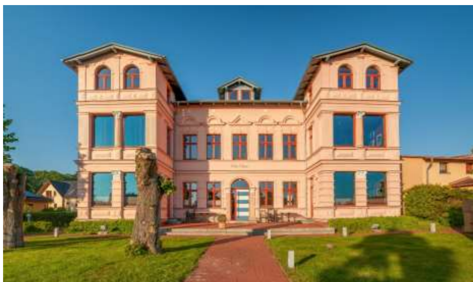
Denkmalsanierung „Villa Maria“ – in Koserow
