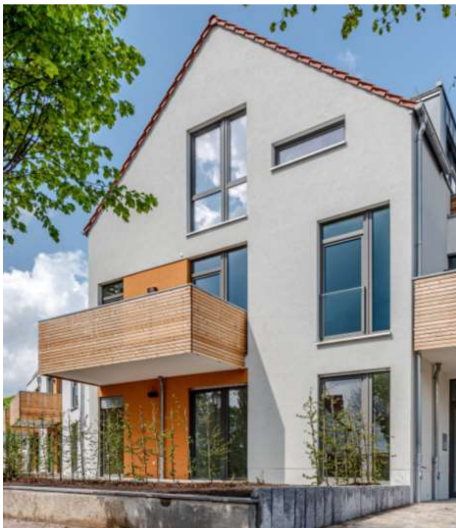
Neubau Mehrfamilienhaus – in Koserow
