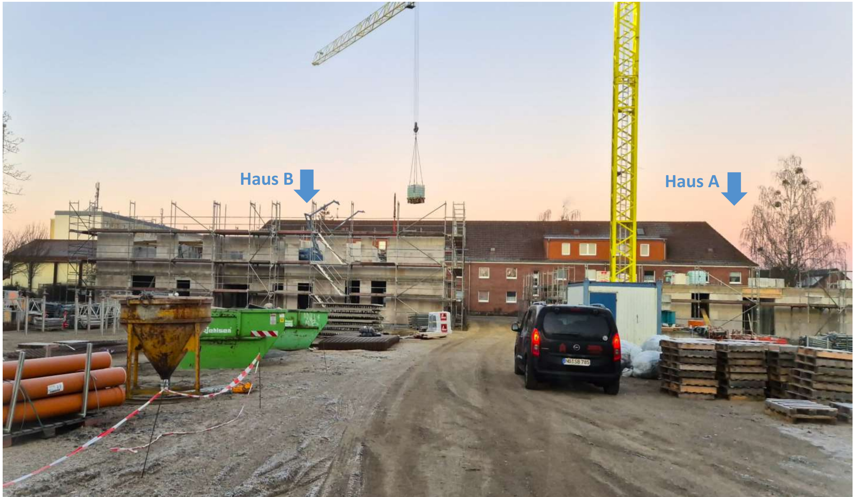
Hofseite Baufortschritt Januar 2025
