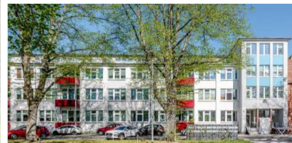
Krankenhausumbau – in Neubrandenburg
