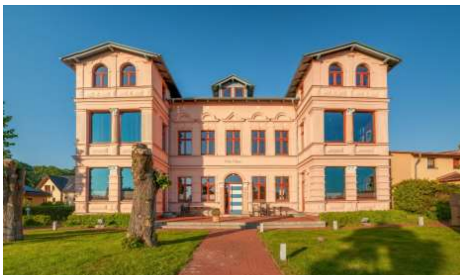
Denkmalsanierung „Villa Maria“ – in Koserow
